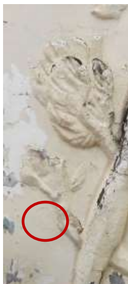
גזע הצמח והעלים (משמאל): התפוררות וסדקים, מקטע חסר (בעיגול אדום)
