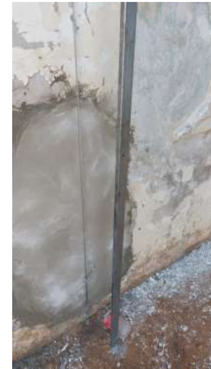
בניית קונסטרוקציית פלדה מול שטח התבליט עם כבלי פלדה מתוחים מצידדיו.
