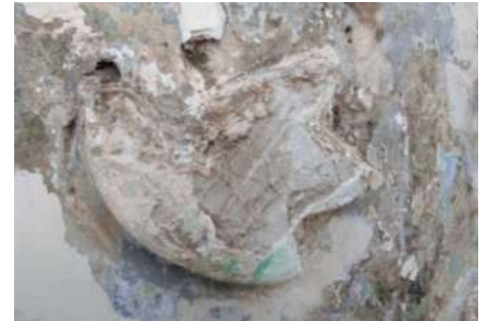
לפני: ניתן לראות לקונה בטיח החושפת את תשתית הבטון המחורצת הקובעת את מתאר התבליט הבסיסי
