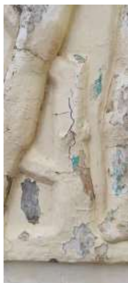
גזע הצמח והעלים (משמאל): התפוררות וסדקים, מקטע חסר (בעיגול אדום)
