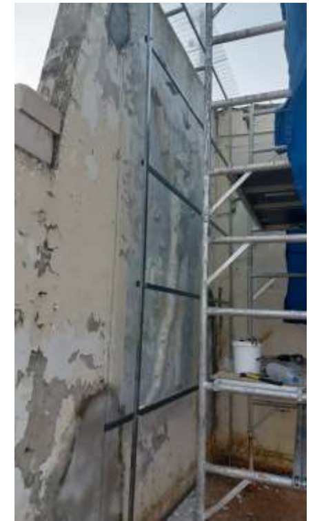
בניית קונסטרוקציית פלדה מול שטח התבליט עם כבלי פלדה מתוחים מצידדיו.
