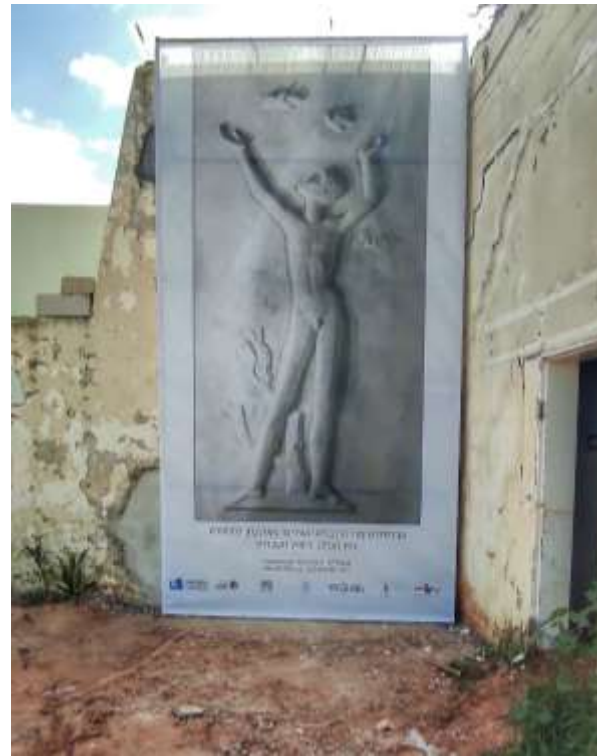
מתיחת בד פלסטי נושם המשמש כהגנה מפני נזקי מזג אוויר ונזקים פיזיים בזמן עבודות צפויות במתחם.
