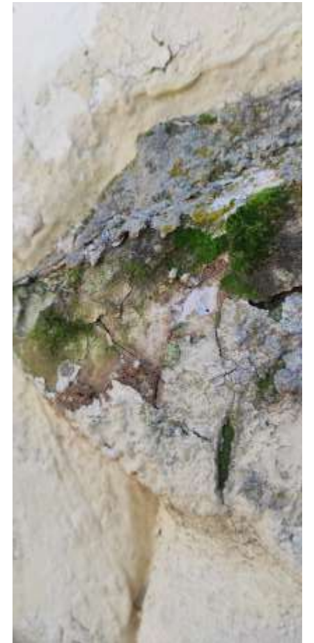
דוגמא לשכבות טיח מאוחרות, נזקי מיקרוביולוגיה, סדקים והתנתקות בפרט סנטר
