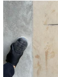
החלקת אזור הדלת האטומה ויישור מפלס הקיר
