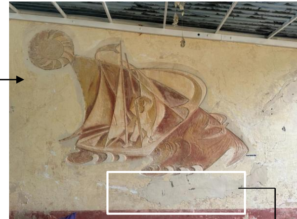
קיר הבסיס לאחר הסרה מכבית של הצבע המאוחר לאחר החשיפה באזור המסומן התגלה מילוי מחומר צמנטי
