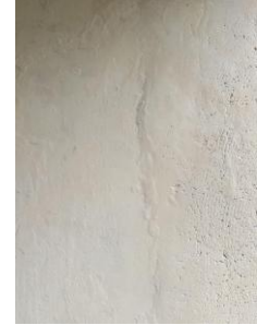
א - חיבור בין הקיר המקורי לבין השלמת בטון מאוחרת לאחר מילוי והשלמות
