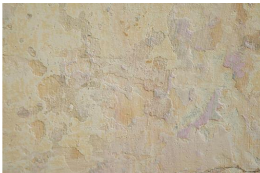
תקריב על שכבות צבעי רקע הקיר (חלק עליון) לאחר חשיפה של שכבת הצבע הפלסטי-אקרילי
