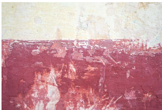
תקריב על שכבות צבעי רקע הקיר (חלק תחתון) לאחר חשיפה של שכבת הצבע הפלסטי-אקרילי
