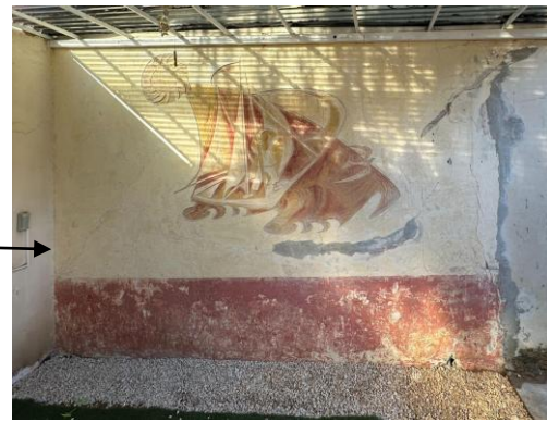
כיסוי צינור הפלסטיק בחצץ
