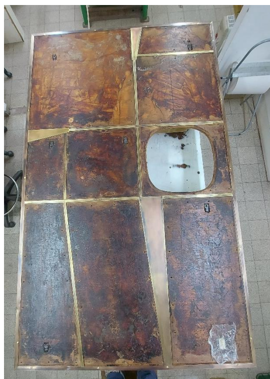
איור 24 – ימין, מבט על לוח העץ הלבוד עם מסגרת פרופיל פליז ופיני ברזל מונחים בשקערוריות מלבניות, פסי פליז מקשרים ברווחים בין לוחות התבליט. שמאל, תחילת הרכבת לוחות התבליט בחלק העליון של הדלת והידוק ברגים מתחת ללוח העץ.
