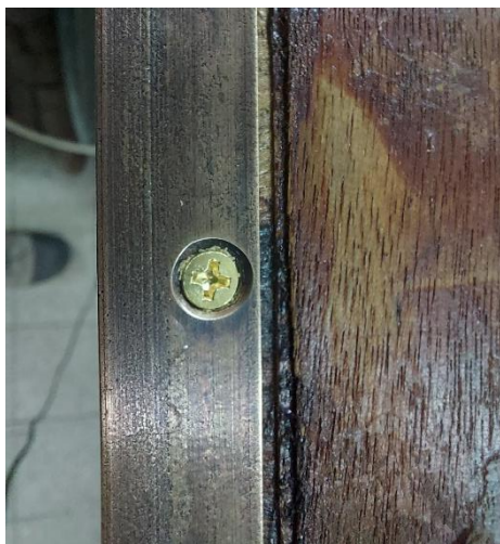
איור 20 – מימין לשמאל, מרכז חור ההברגה בתותב בעזרת דקר, הברגת בורג עץ חדש מפליז, מראה מקרוב של הבורג המהדק את מסגרת פרופיל הפליז לעץ הלבוד.
