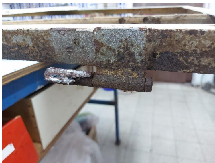
איור 11 – מבט מקרוב על פני השטח החיצוניים של המסגרת הברזלית, החלודה הרבה ונזקיה, פנים המסגרת היה חלוד אף יותר כפי שאפשר ללמוד מהלכו הרב ואבדן חומר מקור שנראה באיור 9.
