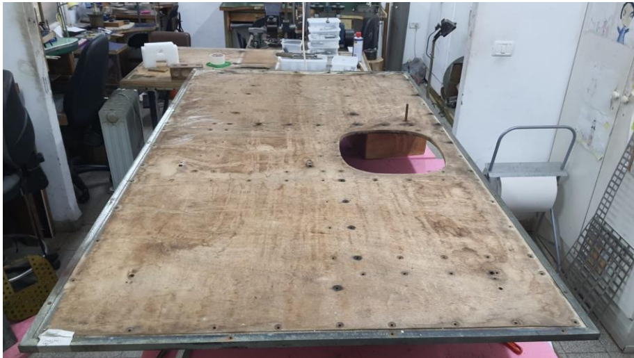
איור 7 – ימין, מבט אחורי על לוח העץ הלבוד עם ברגי ההידוק שמחברים את לוחות התבליט. שמאל, מראה הלוח עם המסגרת מנתך הנחושת לאחר הפרדת לוחות התבליט
