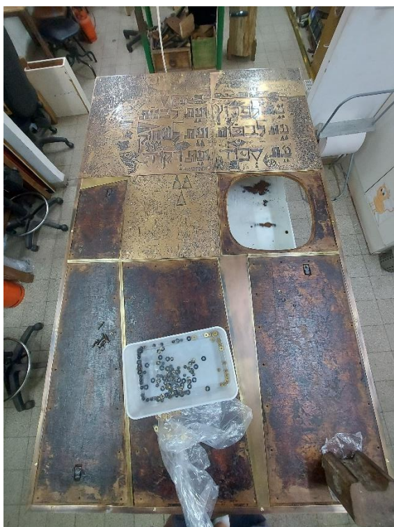
איור 24 – ימין, מבט על לוח העץ הלבוד עם מסגרת פרופיל פליז ופיני ברזל מונחים בשקערוריות מלבניות, פסי פליז מקשרים ברווחים בין לוחות התבליט. שמאל, תחילת הרכבת לוחות התבליט בחלק העליון של הדלת והידוק ברגים מתחת ללוח העץ.
