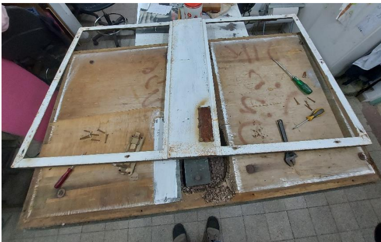
איור 5 – ימין, מבט מקרוב על בורג המסגרת. שמאל, מבט על המסגרת מופרדת מגוף העץ
